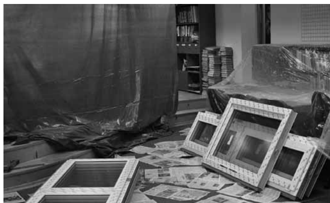
Remont Gminnej Biblioteki Publicznej
