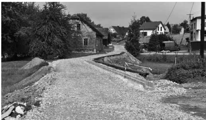
Remont ul. Okrężnej
