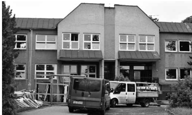
Modernizowany budynek przedszkola w Bestwinie
